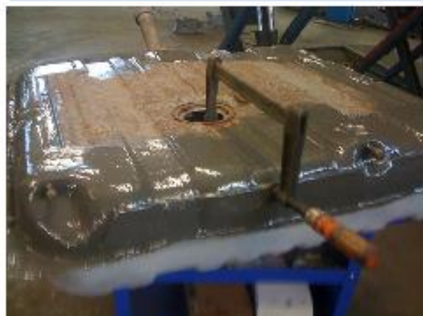
Opravená nádrž před umístěním do auta
