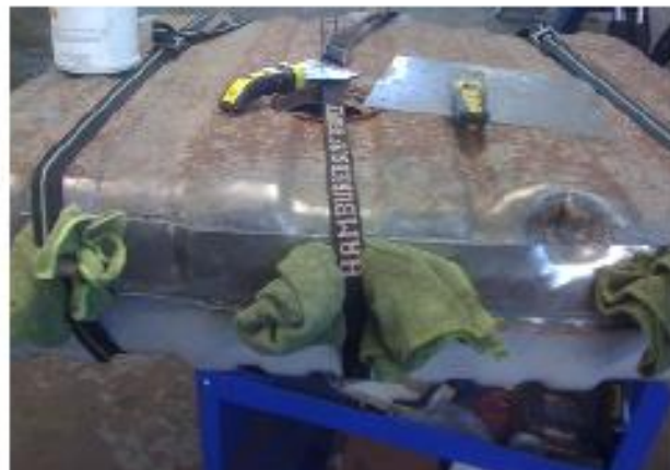
Plechové pásky zabezpečeny pomocí popruhů
