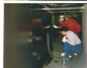
Beschichtung eines Mischbeckens
